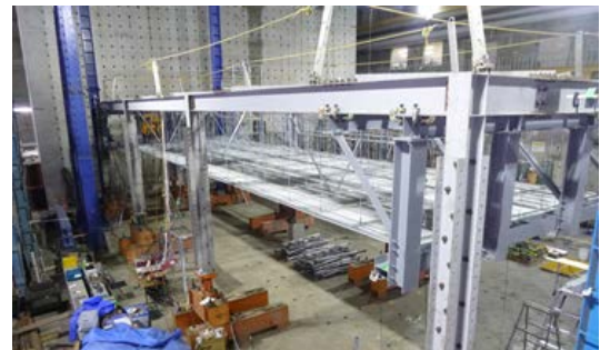
写真－4 試験体の外観（加振実験）
