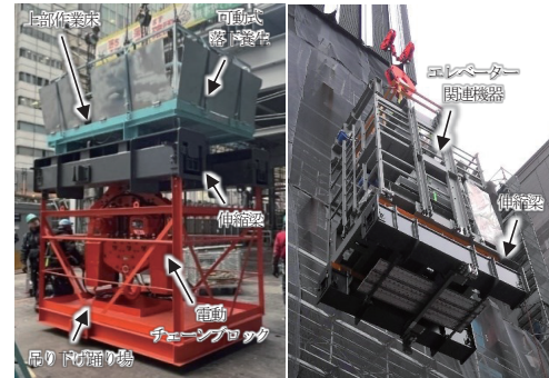
本設エレベーター仮設利用技術 ユニット
