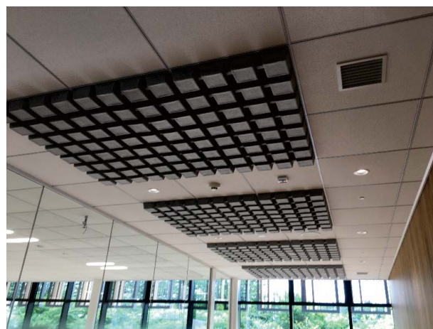
写真6 グリーンオフィス棟設置状況
