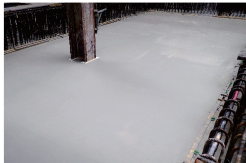
写真 コンクリートの打設完了後の状況
